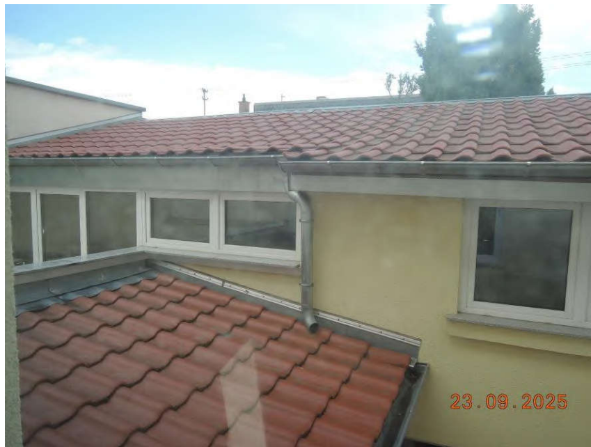
Bild 19: Blick auf die Nebengebäude vom Treppenhaus aus
