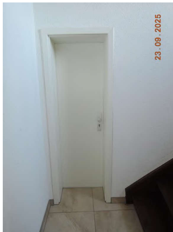
Bild 10: Tür zum Anbau (Abstellraum und WC) der Wohnung im Obergeschoss
