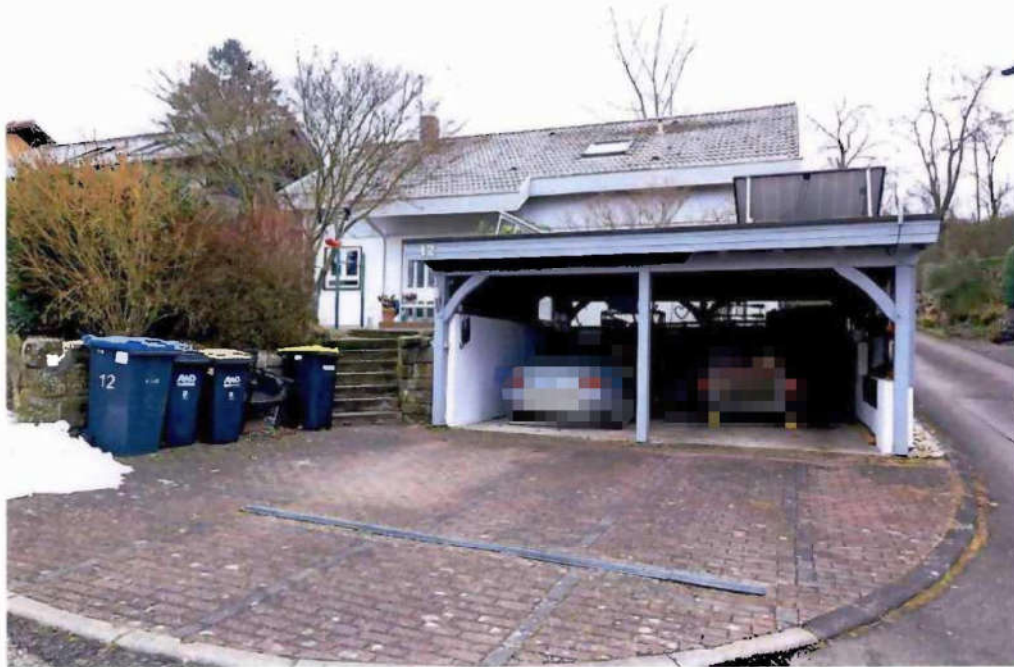
Blick auf das zu bewertende Einfamilienwohnhaus nebst Doppelcarport von Norden.
