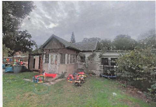
Bild 8: Ostseite Wohnhaus m. Anbau
