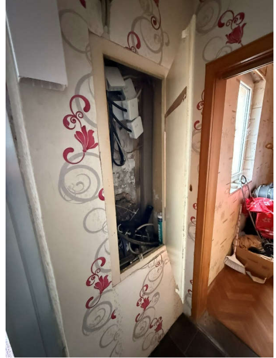
Verteilerdosen / Elektrokabel Wand Flurbereich
