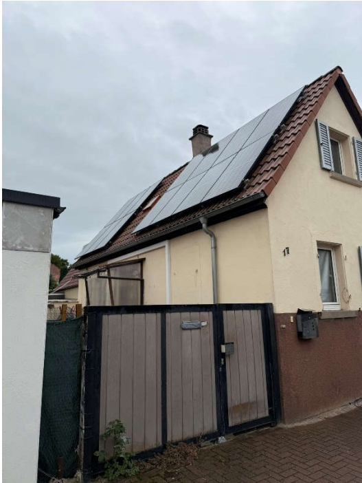
Seitenansicht Wohnhaus / Ansicht PV-Anlage (PV nicht in der Wertermittlung enthalten; siehe Erläuterung Ziff. 1.3)
