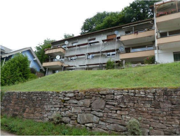
Südansicht Gebäude Nr. 19
