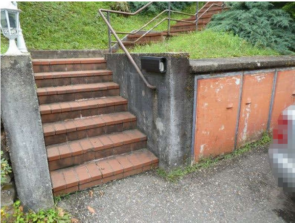
Treppenaufgang, Ort beton, Fliesenbelag, Eisenhandlauf
