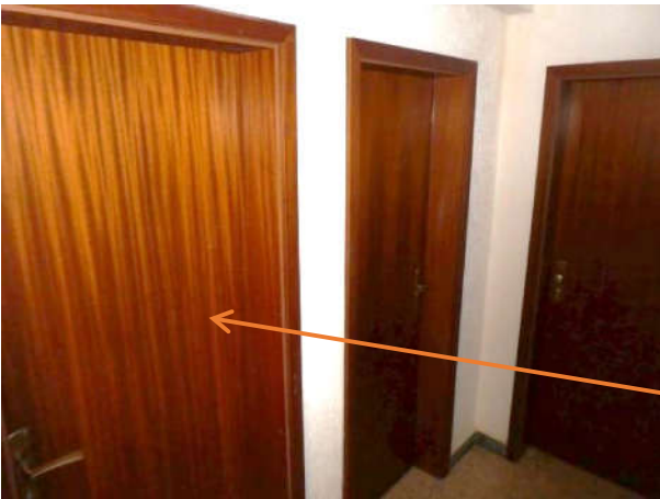
Erschließungsflur im Erdgeschoss
