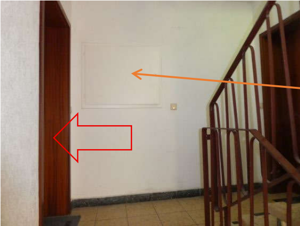
Treppenhausvorplatz, Pfeil zeigt Wohnungszugang
