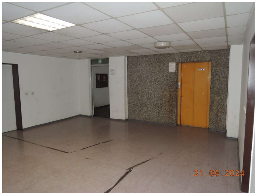
Abb. 7: Flur und Aufzug 5. OG
