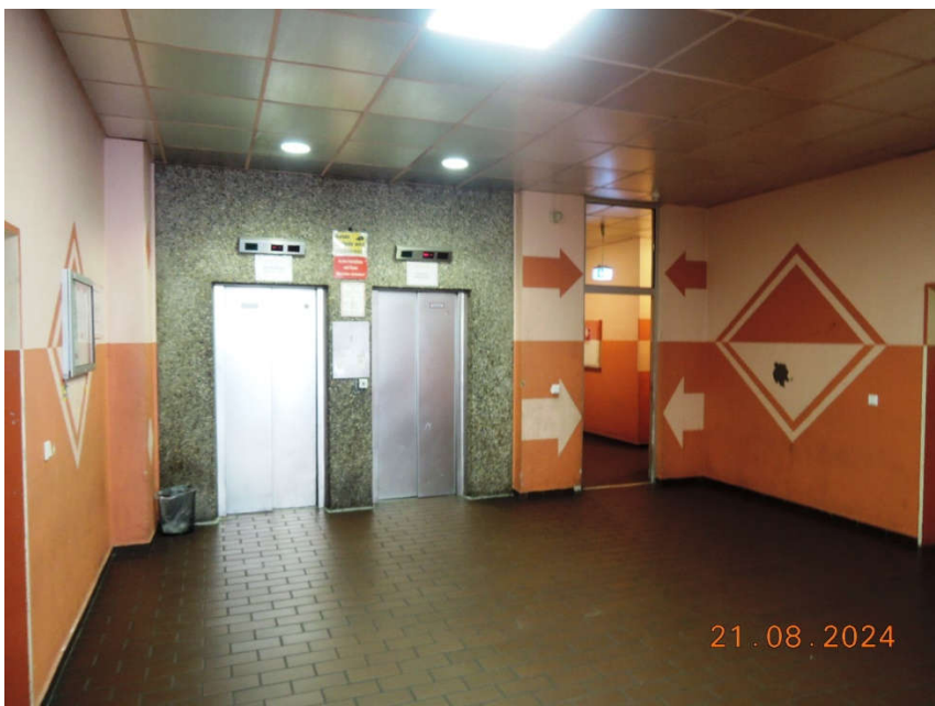
Abb. 4: Eingangsbereich und Aufzüge
