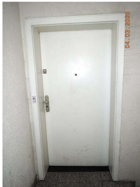
Abb. 10: Wohnungseingang im 1. OG
