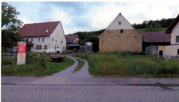
Gesamtansicht aus Süden (Dimbacher Straße / Ortsdurchfahrt)
