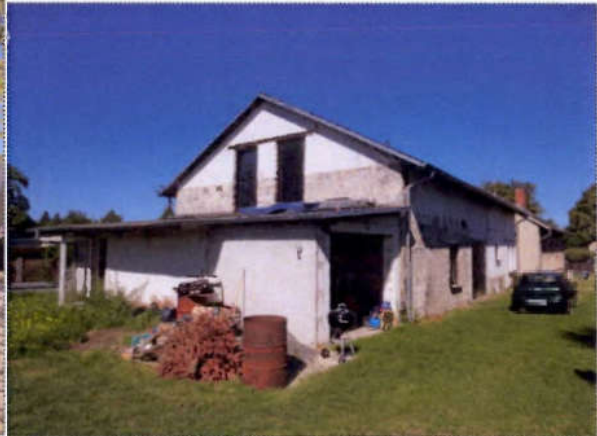
Stall/Scheune und Garage
