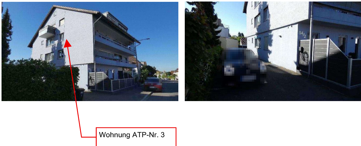
Bild 7: Außenansichten Gebäude und Grundstück (ff.)
