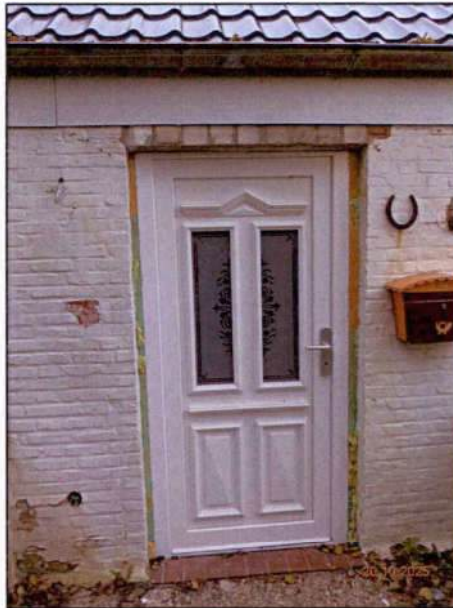
Blick auf die Hauseingangstür
