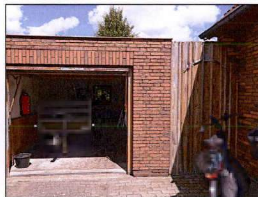
Blick auf die Garage
