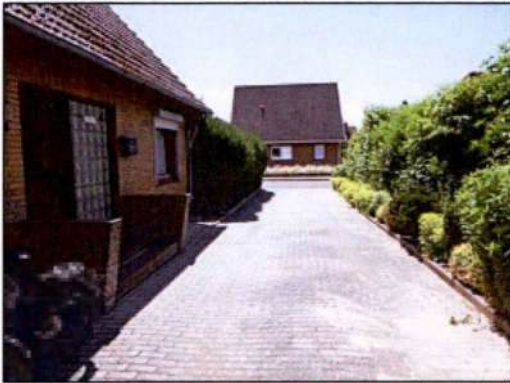
Nordwestfassade mit Blick zur Straße
