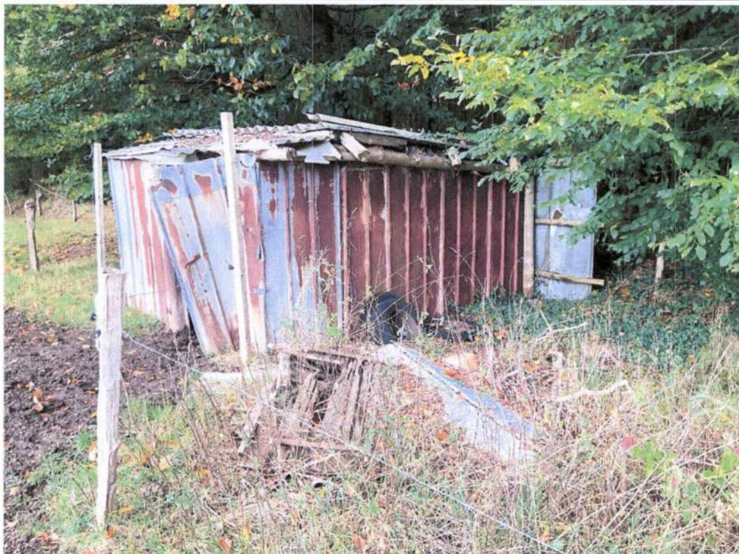
Bild 15: Leichtbauschuppen: Blick von Südosten mit davorliegenden Altreifen mit Felgen, Blechtafeln, Bauholzresten etc.
