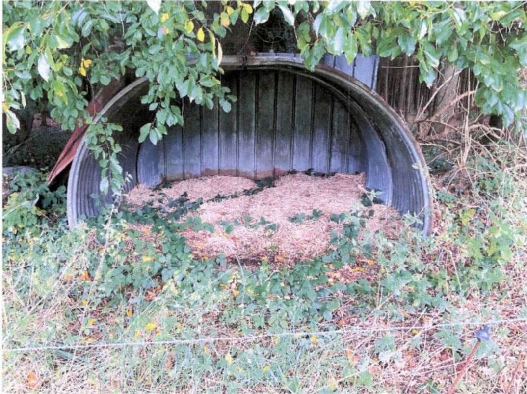
Bild 13: Rundblechschuppen: Blick von Süden
