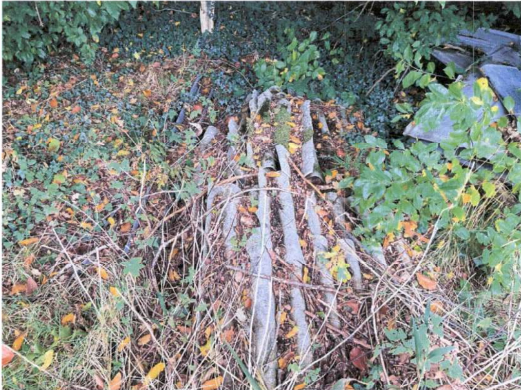
Bild 17: Blick auf die Eternit- und Blechplatten
