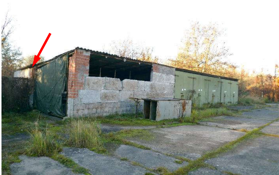
Foto 12, Lkw-Reihengarage (Geb. 2) mit Anbau (Rohbau), Pfeil weist zum Überbau auf dem Nachbarflurstück 367/172, einem Gehölz, Südwestansicht
