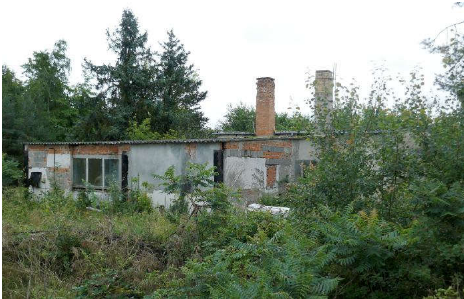
Foto 11, Rückseite des in der Instandhaltung vernachlässigten Lagergebäudes (Geb. 1), Nordostansicht
