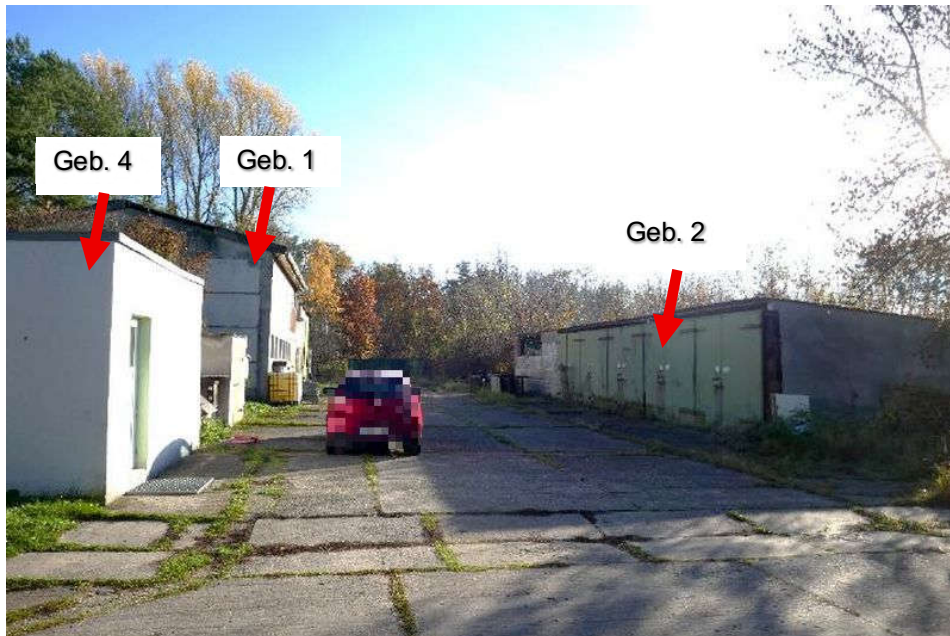
Foto 9, Lagergebäude (Geb. 1) und Lkw-Reihengarage (Geb. 2) und betonierte Verkehrsfläche, im Vordergrund Gerätehaus (Geb. 4), Westansicht
