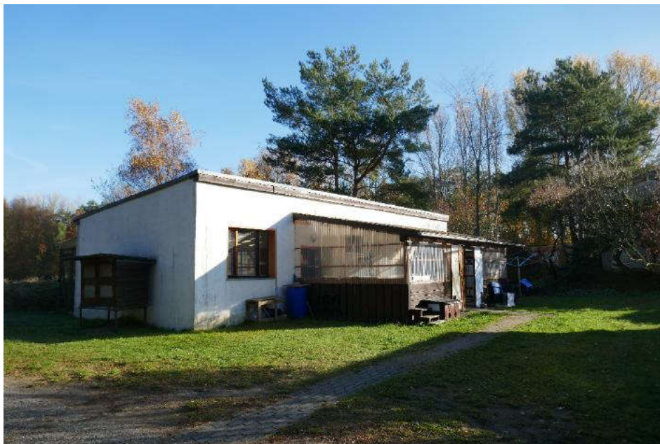
Foto 6, Vereins-/ Funktionsgebäude (Geb. 3) mit eingehauster Eingangsüberdachung, Mieter hat dieses Gebäude auf eigene Kosten instandgesetzt, Südwestansicht
