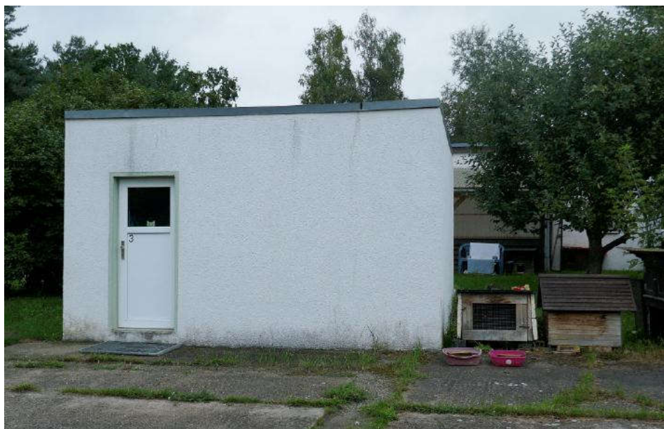
Foto 8, Gerätehaus (Geb. 4), Mieter hat dieses Gebäude auf eigene Kosten instandgesetzt, Südansicht
