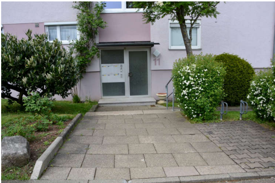
Bild 4: Ostansicht Hauseingangsbereich „Kolpingstraße 11“
