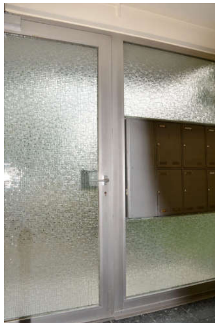
Bild 14: Haustür mit Briefkastenelement, freie Lüftung, Zustand dem Baujahr entsprechend
