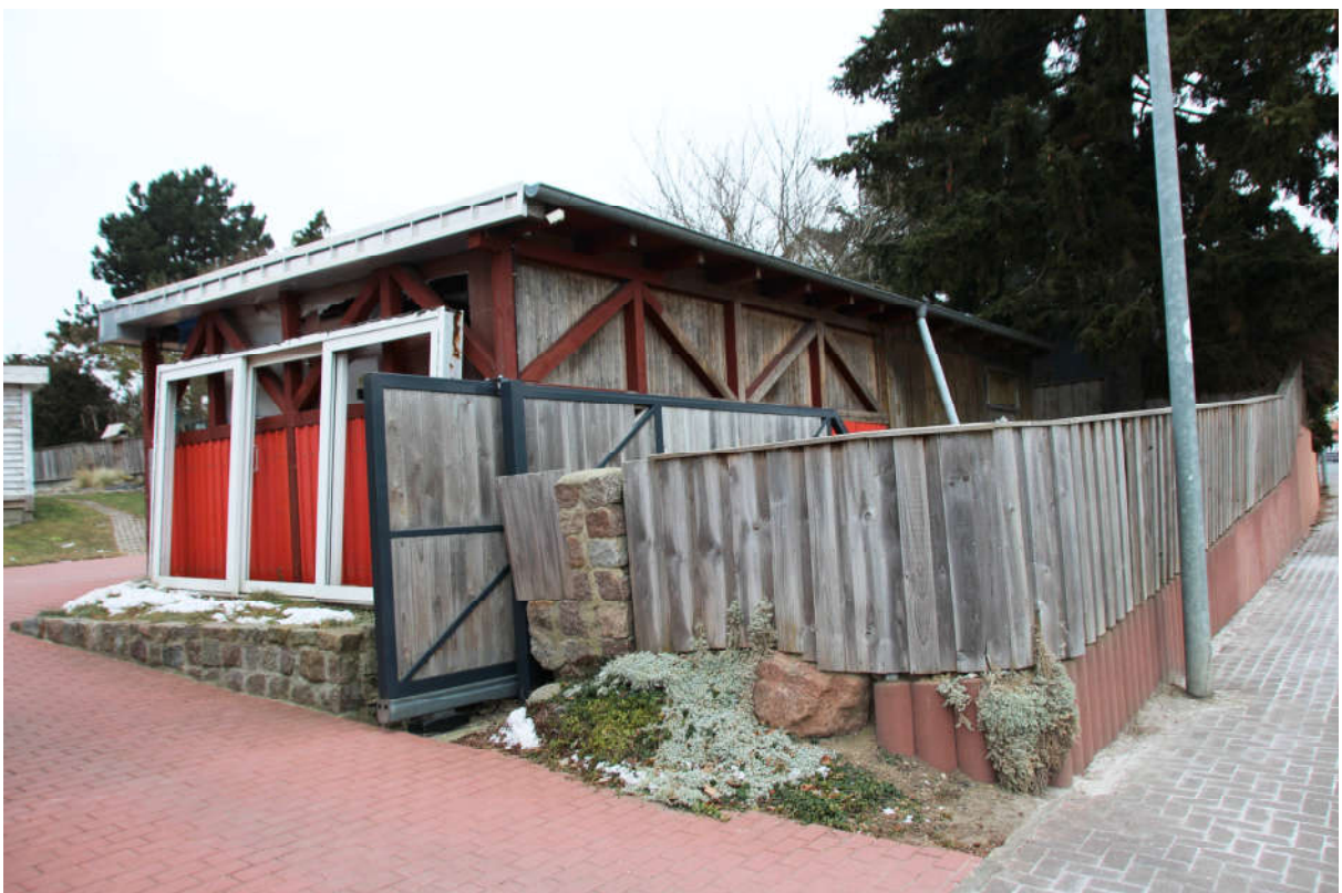
Bild 6: Sicht auf den Unterstellschuppen auf dem Grundstück
