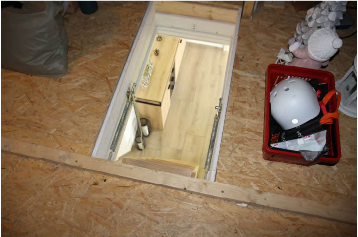
Bild 33: Einschubtreppe zum Dachraum
