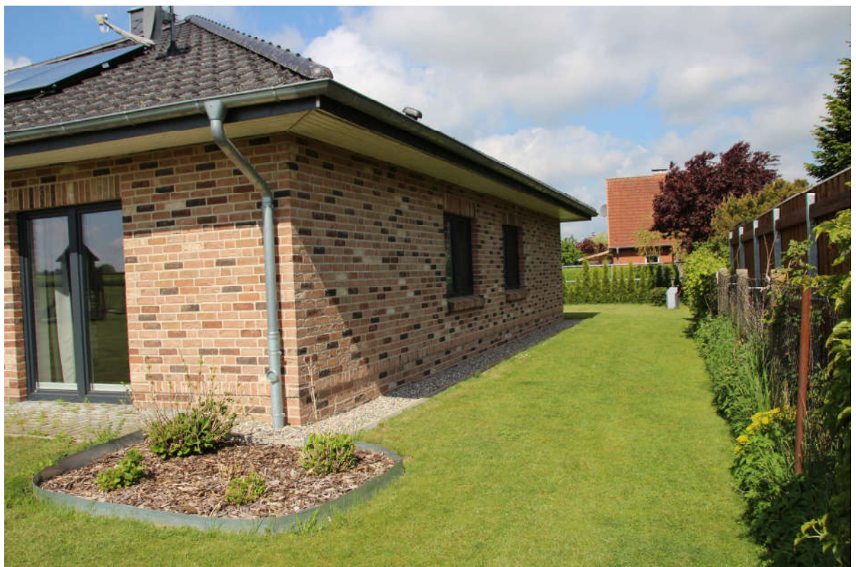
Bild 8: Detail der Außenfassade
