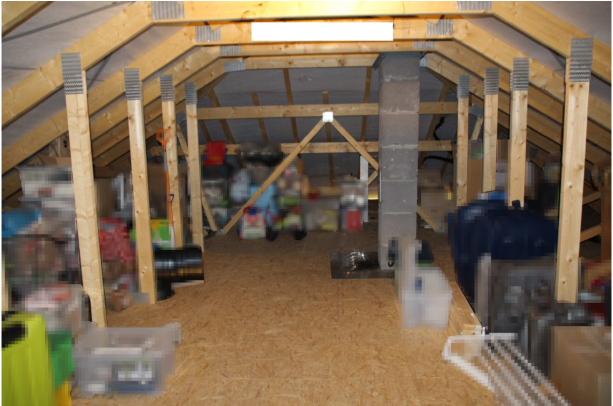
Bild 31 und Bild 32: Blick in den Dachraum
