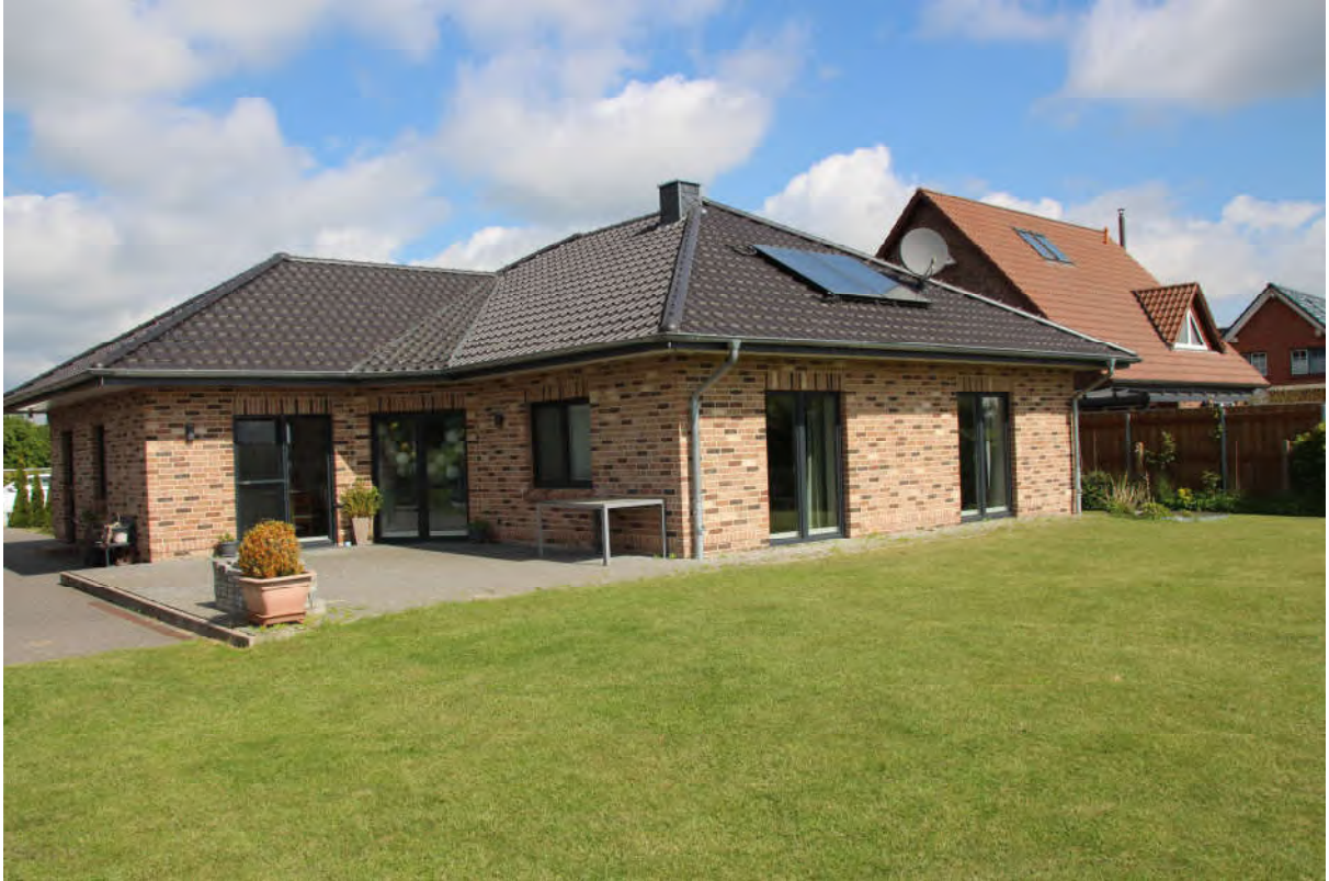
Bild 5: Südansicht des Einfamilienhauses
