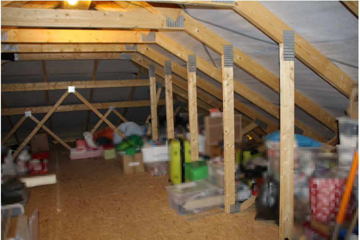
Bild 29 und Bild 30: Dachraum des Einfamilienhauses
