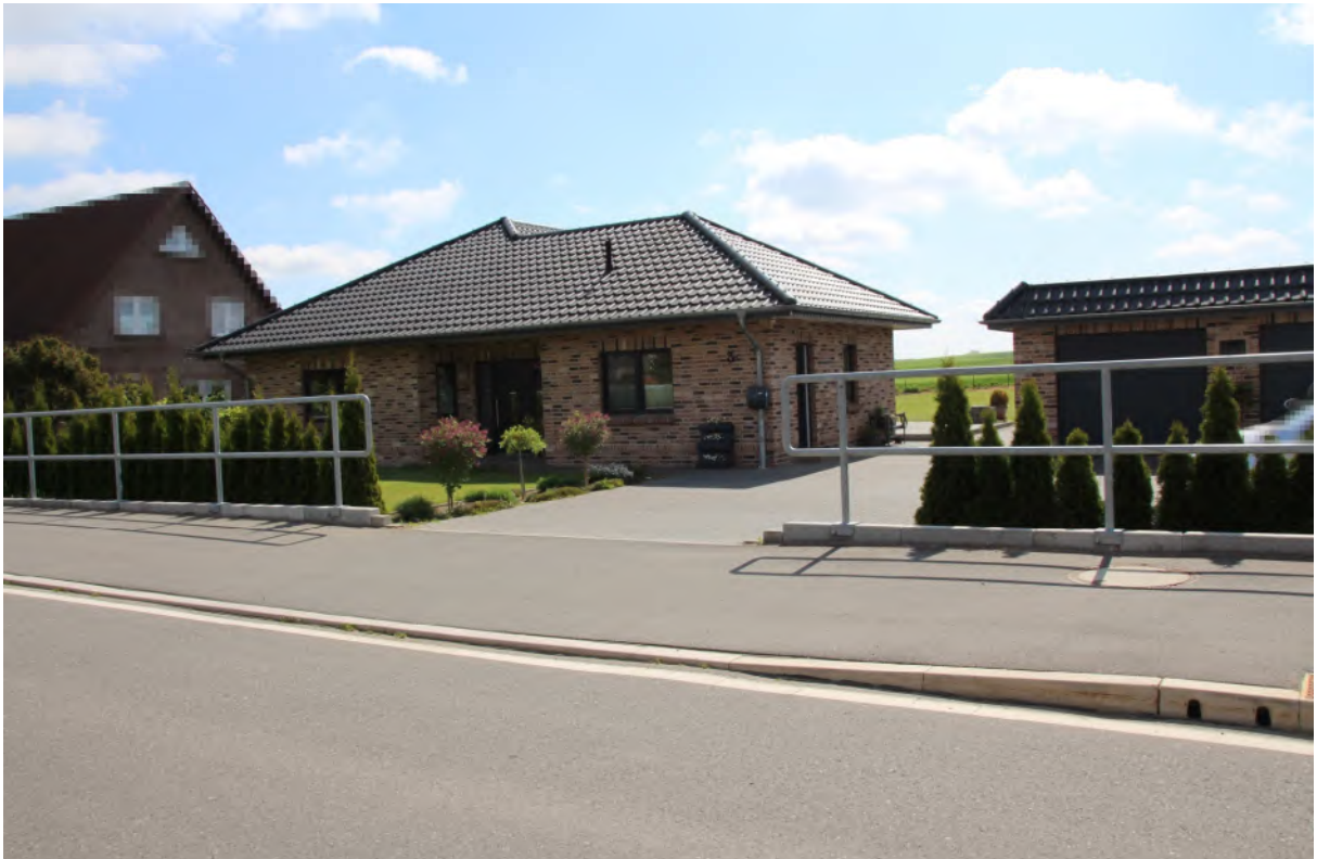
Bild 1: Blick von der Hauptstraße auf den Winkelbungalow
