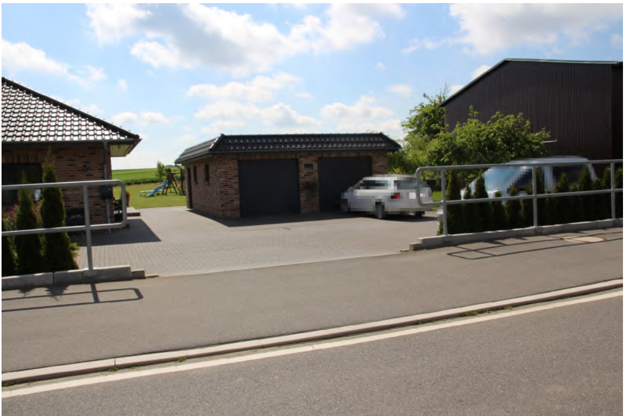
Bild 2: Sicht auf die Zufahrt zum Grundstück und die Doppelgarage
