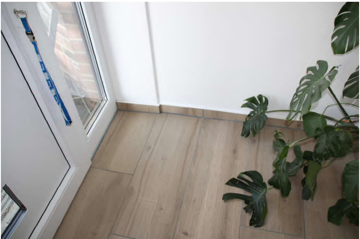
Bild 34: Detail des Eingangsbereiches
