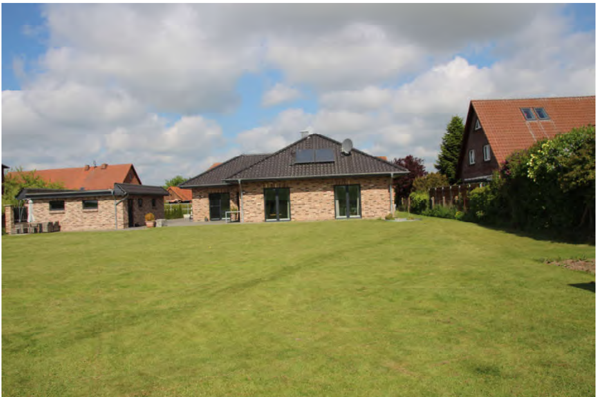
Bild 6: Blick vom hinteren Teil des Grundstückes auf die Bebauung
