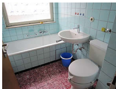
Bad, Zustand aus 1969
