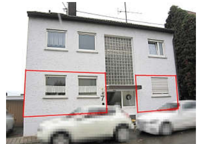
Nordostansicht Wohnung Nr. 1 rot umrandet
