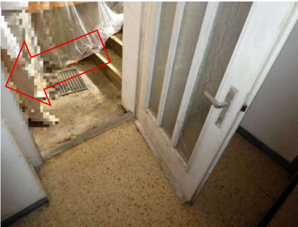
Zugang vom Treppenhaus
