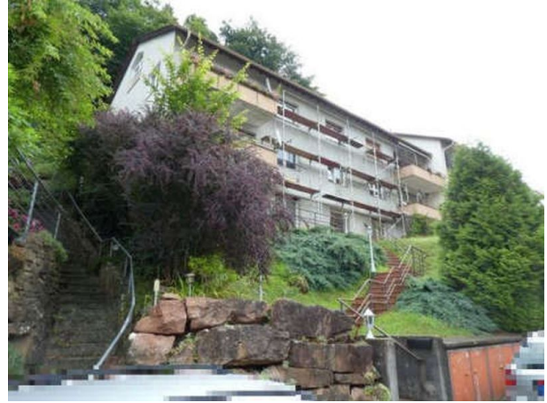
Südwestansicht Gebäude Nr. 19
