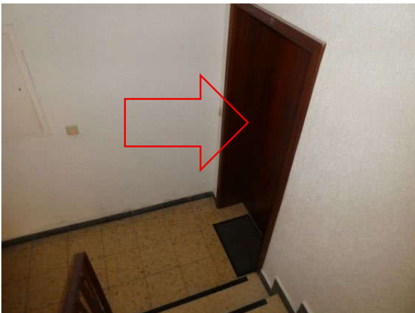
Treppenhausvorplatz, Pfeil zeigt Wohnungszugang
