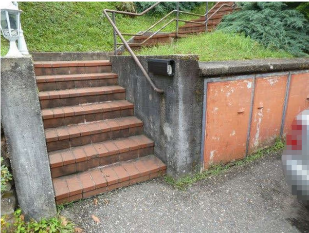
Treppenaufgang, Ortbeton, Fliesenbelag, Eisenhandlauf
