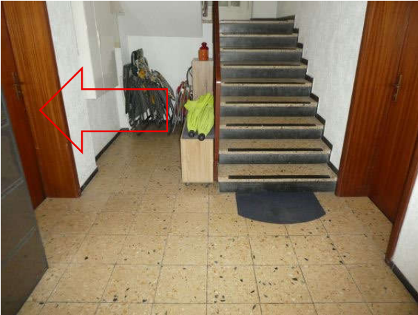
Treppenhaus im EG des Hauses Nr. 21
