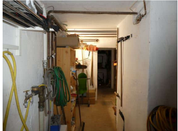
Zugang zum Heizungsraum
