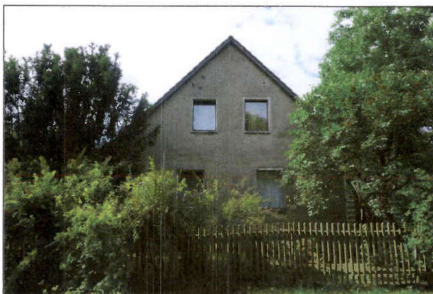
Ansicht Ludwigsfelder Str. 20, Einfamilienhaus
