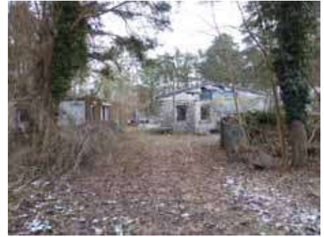
Blick in Richtung Werkstattgebäude und Container
