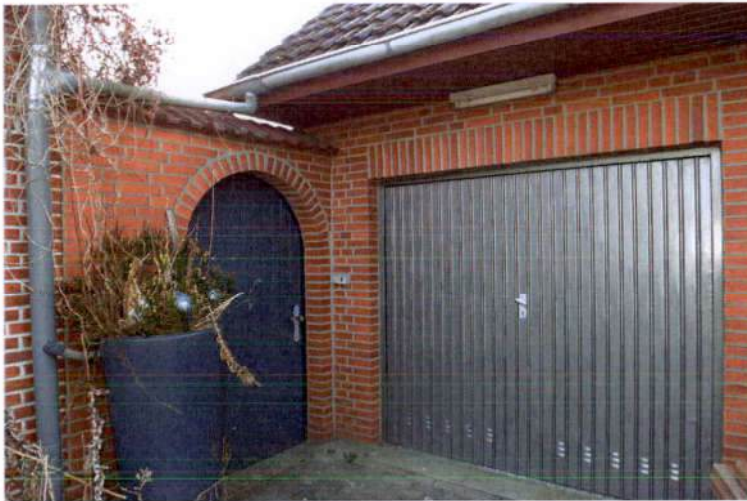
7. Garage u. Tür zum Hof
