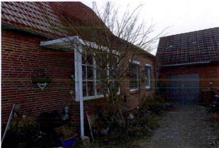
5. Hauseingang und Garage
