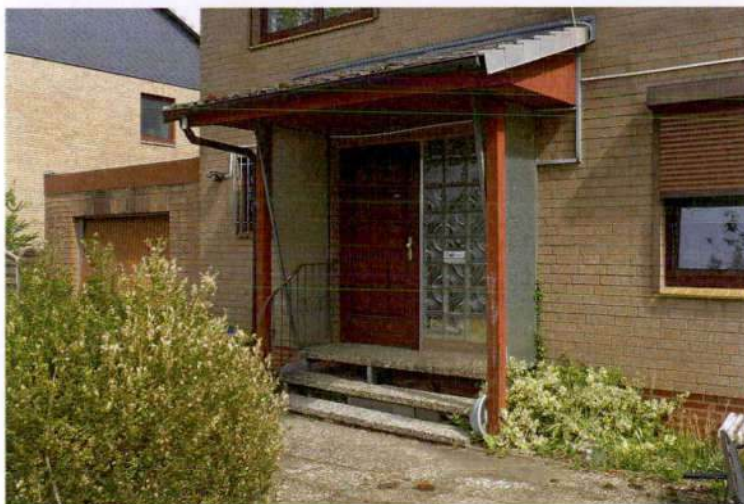
Gebrochene Platten u. defekter Unterbau
