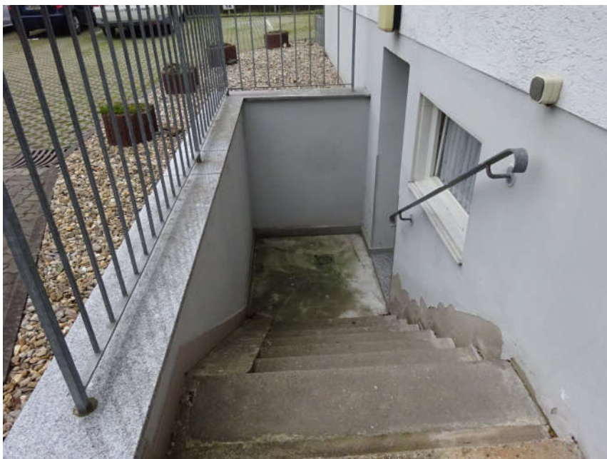
Bild 4: Kellereingangstreppe an der Wohnhausnordseite
