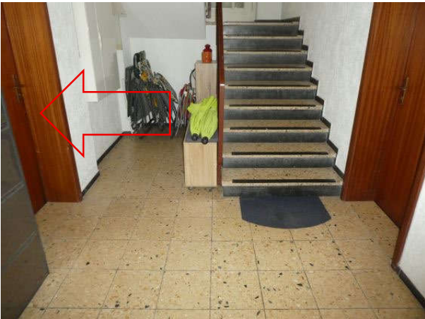
Treppenhaus im EG des Hauses Nr. 21
