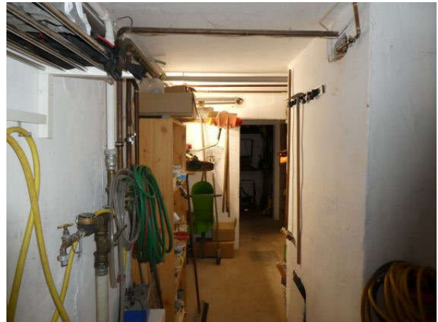
Zugang zum Heizungsraum
