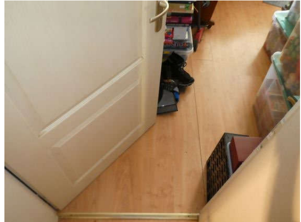
Zimmertüre zum Kinderzimmer
