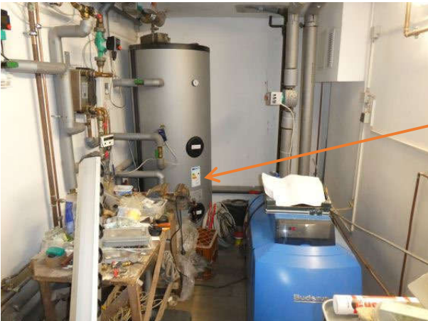
Heizungsraum, Öl-Zentral-Heizung
