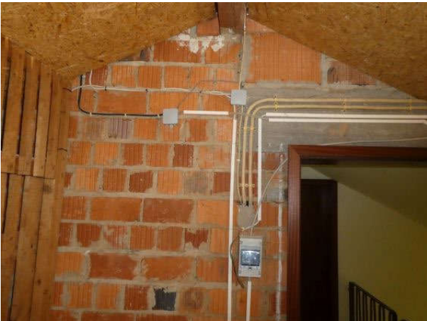
Innenwand im DG unverputzt, Ziegelmauerwerk
