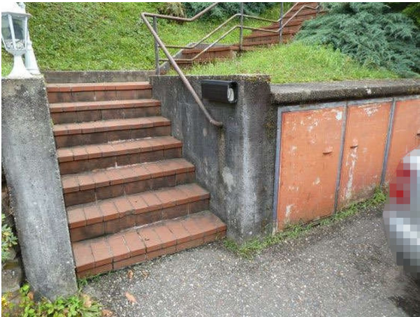
Treppenaufgang, Ort beton, Fliesenbelag, Eisenhandlauf
