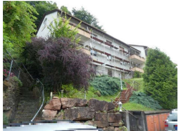
Südwestansicht Gebäude Nr. 19
