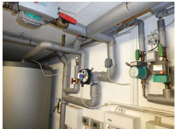
Verrohrung, Dämmung wärmeleitender Rohre vorhanden
