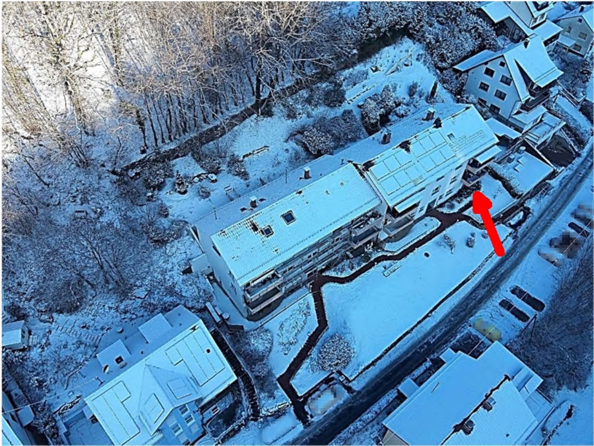
Abbildung 46 Luftbildaufnahme, Lage der Wohnung siehe Pfeil
