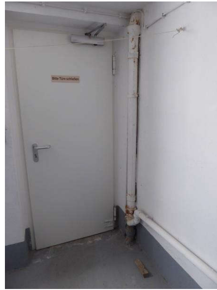
14. Korrosion an Rohrleitungen
