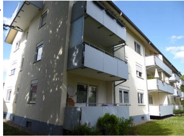
2. Blick von Südwesten
