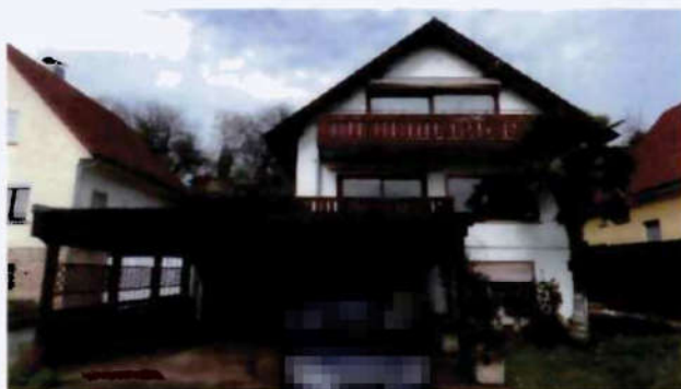
Ansicht Wohnhaus aus Süden
