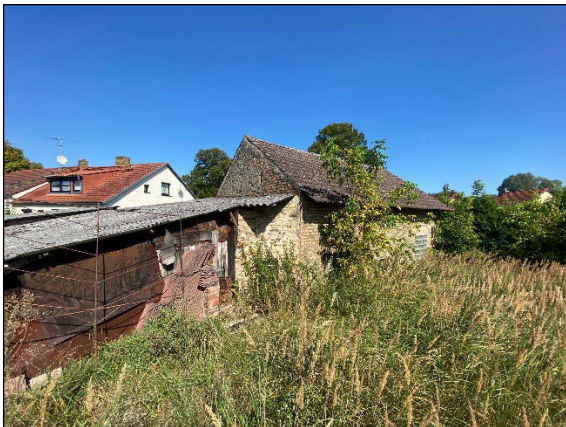
Bild 7: Rückansicht Schuppen und Scheune
