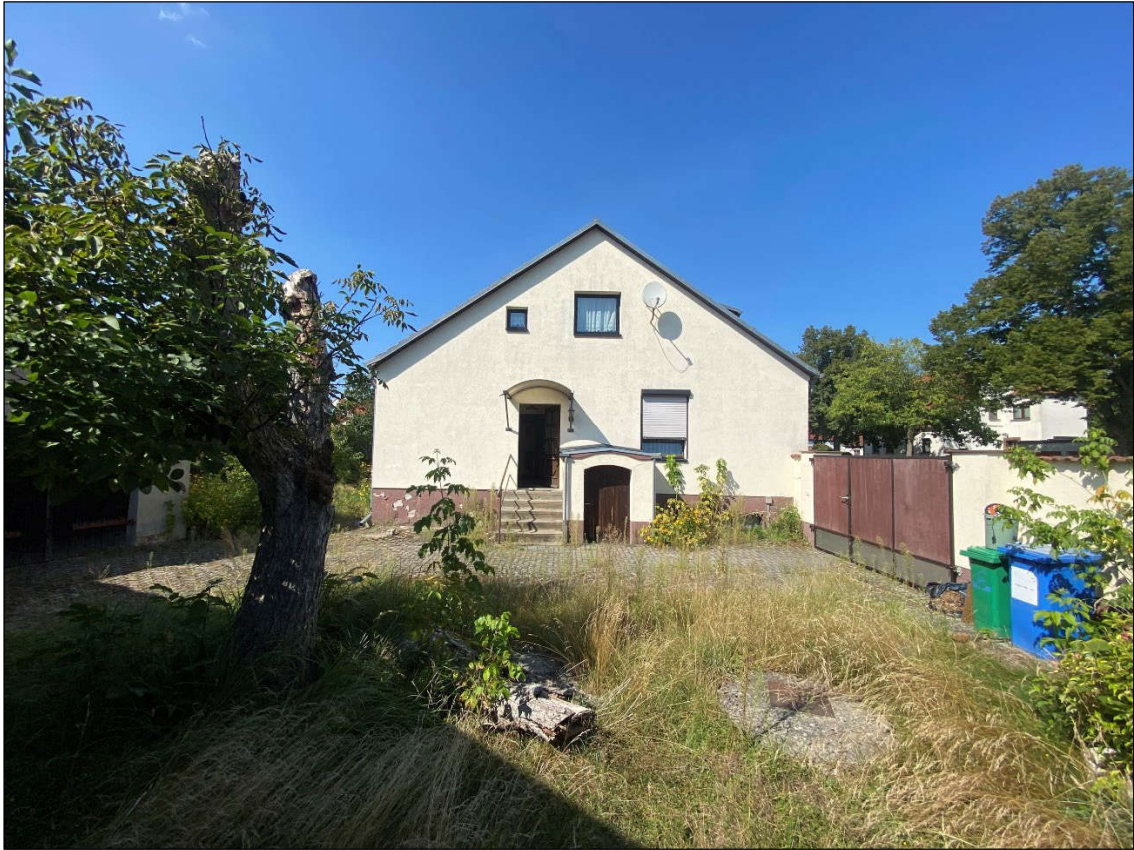
Bild 3: Giebelansicht (Süden) Wohnhaus
