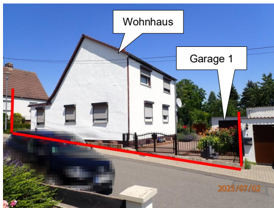
Blick von der Straße Blick etwa Richtung Osten
