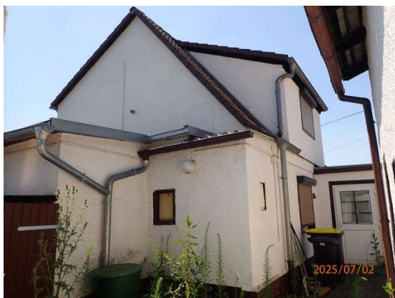
Blick zur Straße etwa Richtung Westen Wohnhaus mit Anbauten
