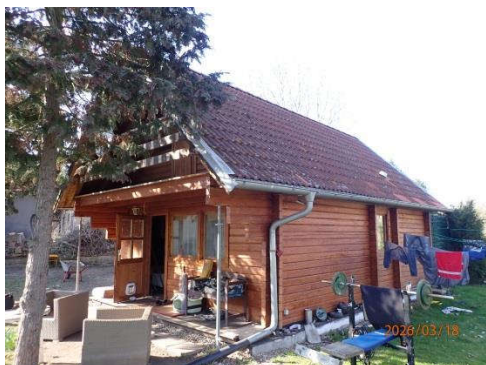
Blockbohlenhaus Blick in etwa Richtung Nordwesten
