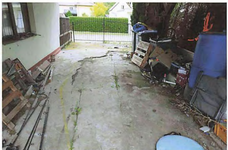
Betonfläche unter dem Carport
