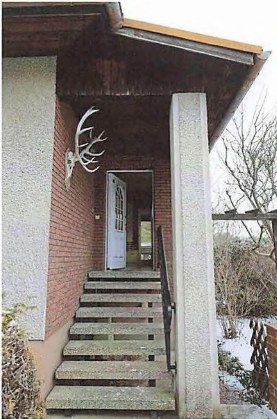
Zugangsbereich zum Wohnhaus
