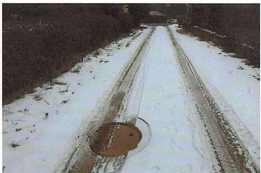
Schachtbauwerk (Schmutzwasser) in der Zufahrt
