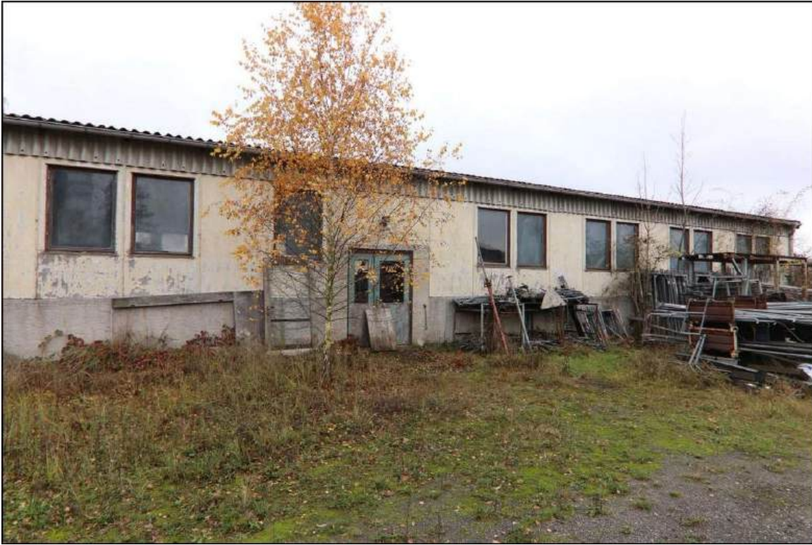
Weiterer Blick auf die Nordseite der Lagerhalle mit den Leichtbauplatten und den Fenstern. Im Erdgeschoss gibt es eine Eingangstür.
