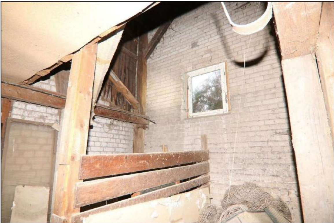
Blick von der Treppe auf den oberen Teil des Lagergebäudes. Hier ist ein höheres Fenster eingesetzt, das durch die Höhe nicht zum Öffnen und zum Schließen zu erreichen ist.
