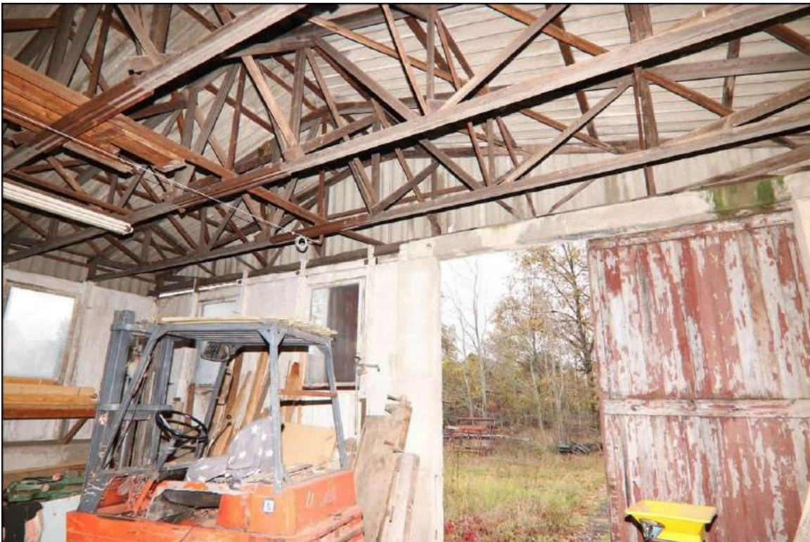
Blick unter das Satteldach der Lagerhalle. Dieser Giebelbereich der Wände wurde massiv ausgeführt. Nach oben hin kann man gut die Dachsparren mit den Wellasbestplatten erkennen. Das Schiebetor ist aus Holz.
