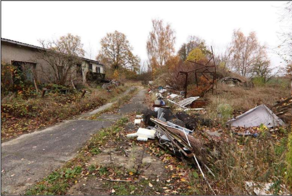
Blick entlang der hinteren Zufahrt südlich der Lagerhalle. Rechts die Fläche wurde bis zur Grenze des Flurstücks mit Müll und altem Baumaterial zugeschüttet.
