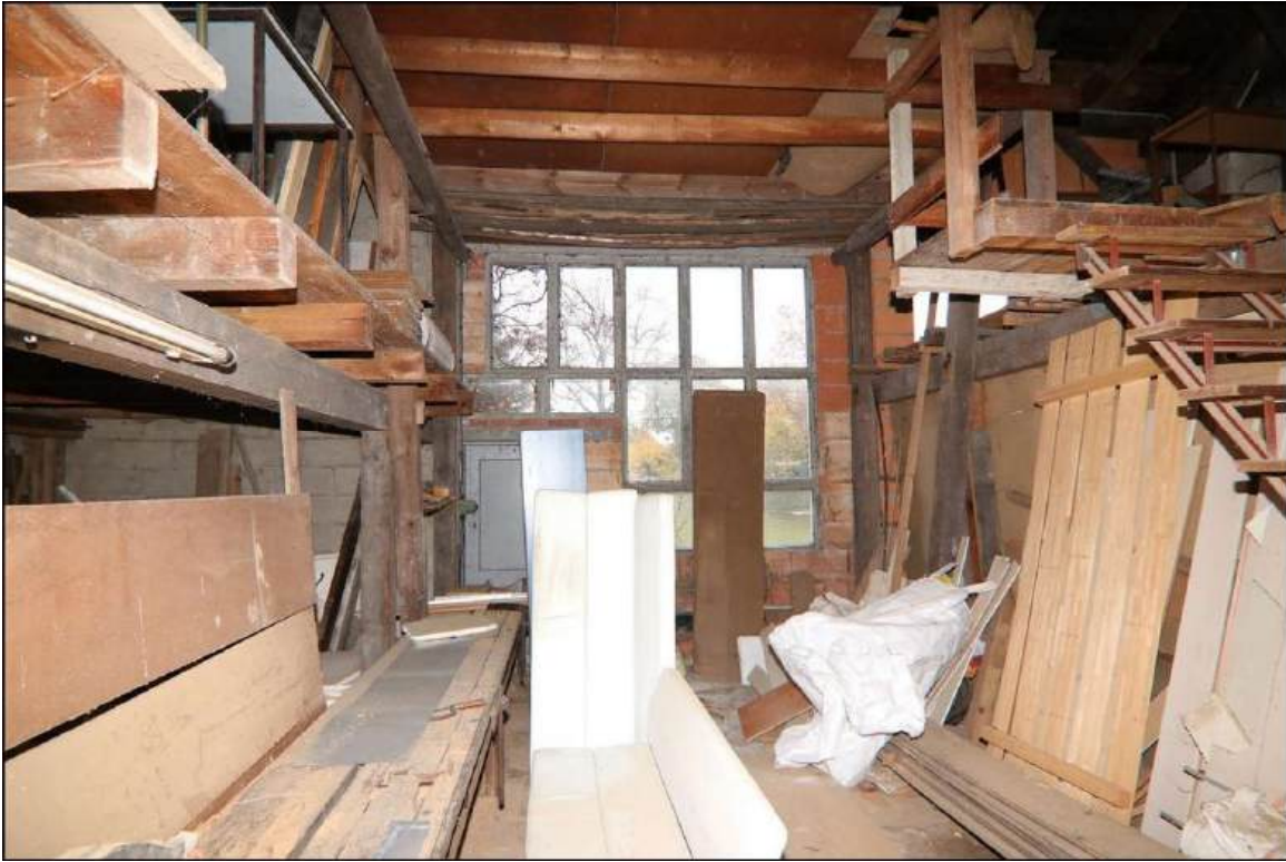
Blick durch das Lager I in Richtung Zufahrt. Rechts ist die Treppe auf die obere Ebene des Lagers zu erkennen. Im Hintergrund ist ein großes Betonfenster mit Metalltür zu sehen.
