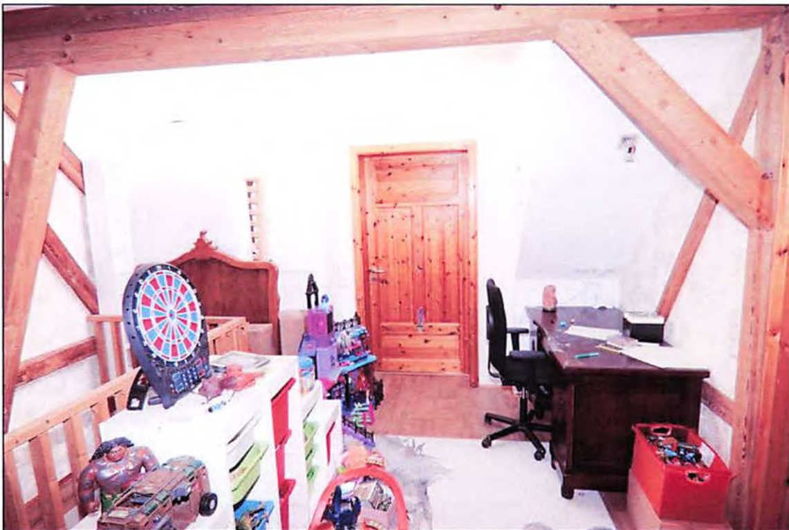
Blick in nördliche Richtung in den Flur im Dachgeschoss. Die Tür im Hintergrund führt in das Kinderzimmer 1. Die Zimmertüren sind erneuert worden und liegen als Holztüren vor.
