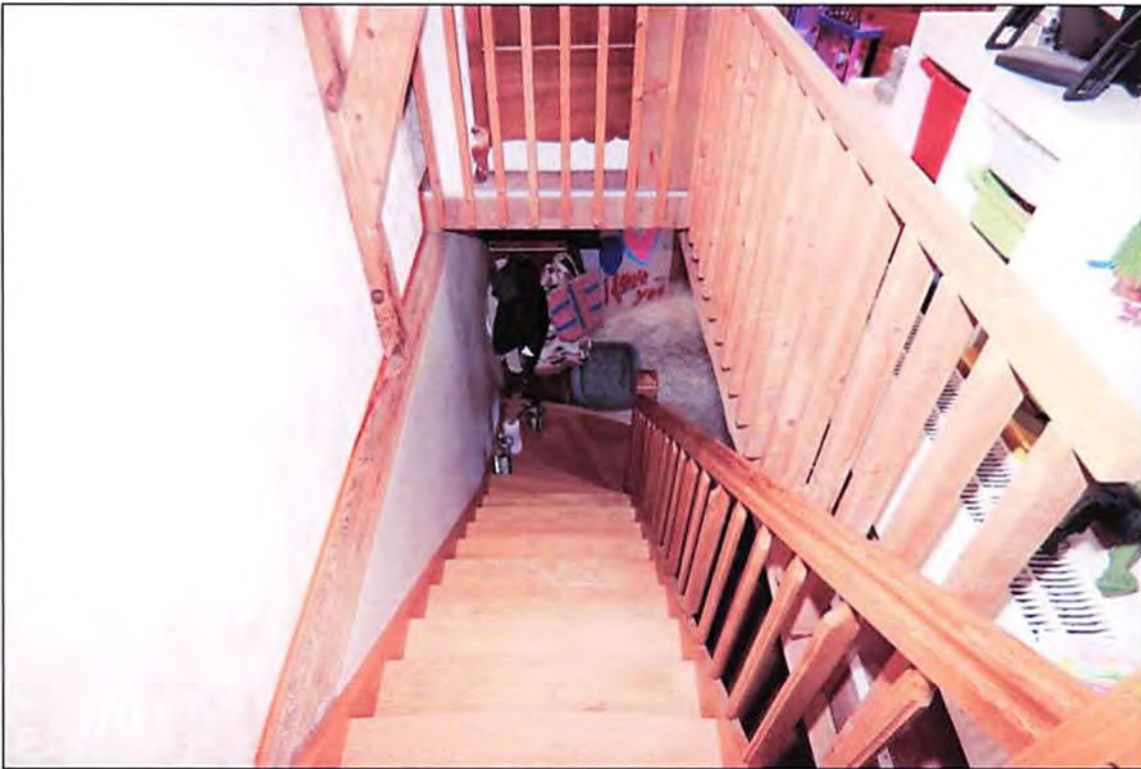
Blick auf die Treppe zum Dachgeschoss, die aus Holz besteht. Die Treppe ist im Zuge der Sanierung neu eingebaut worden. Das Geländer und die Brüstung bestehen ebenfalls aus Holz.
