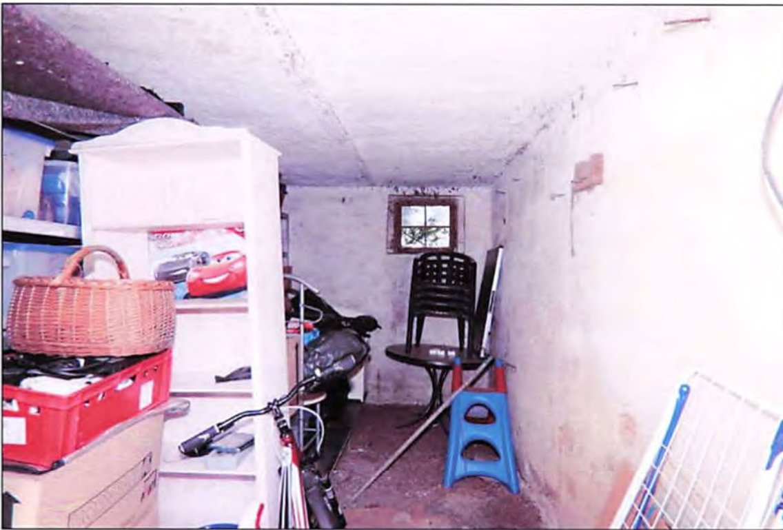
Blick in den Lagerraum 1 im Nebengebäude. Die massiven Wände sind früher verputzt worden. Gut erkennbar ist auch die massive Decke mit den Metallträgern. Im Hintergrund ist ein kleines Fenster vorhanden, das in nördliche Richtung zeigt.
