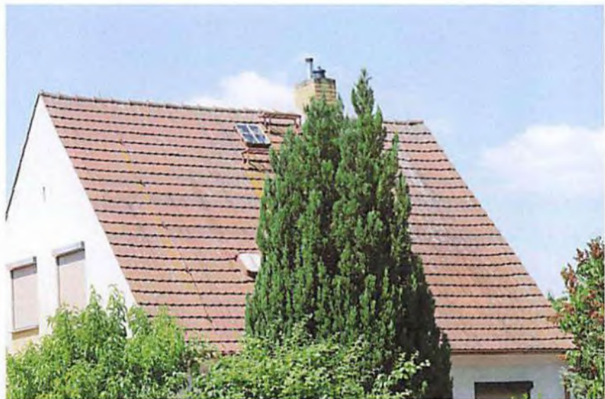
Verformungen in der Dachfläche
