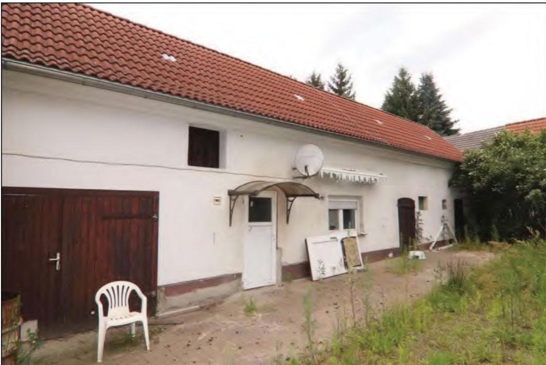
Blick in nördliche Richtung auf das Wohnstallhaus. Hinter dem Garagentor befindet sich ein kleiner Lagerraum. Die Eingangstür zum Flur 2 wurde überdacht und daneben ist das Wohnzimmerfenster erkennbar. Auf der rechten Seite werden der Kaninchenstall sowie ein ehemaliger Stall betreten.
