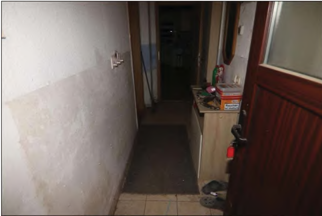
Blick in den Flur 1 im Wohnbereich des zu bewertenden Wohnstallhauses. Auf der rechten Seite ist die Eingangstür erkennbar. Diese besteht aus Kunststoff und besitzt im oberen Bereich einen Ornamentglasausschnitt. Der Flur ist gefliest und die Wände wurden früher gestrichen. Im Hintergrund schließen sich die Zugänge zum Wohnraum, zur Küche und zum ehemaligen Bad (v.l.n.r.) an.
