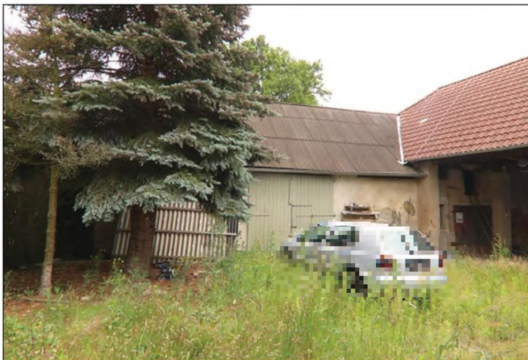
Blick in südöstliche Richtung über den Hof des Flurstücks auf die Scheune. Die Scheune wird durch ein großes Holztor verschlossen, in dem sich eine Schlupftür befindet. Auf der rechten Seite ist ein Teil der Hausdurchfahrt zu sehen.
