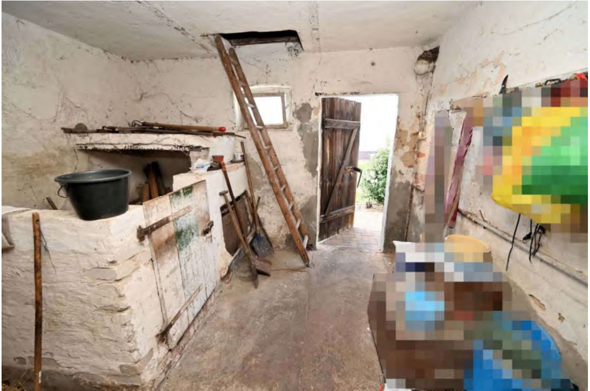
Abb. 29: Nebengebäude B, Erdgeschoss, ehem. Stall
