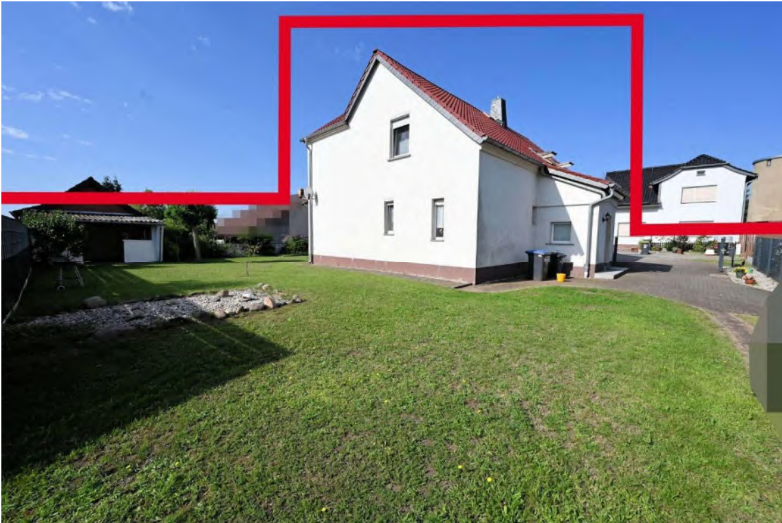
Abb. 3: Grundstück- und Gebäudeansicht Gebäude A, links Freisitz, Blickrichtung Südwesten, Kennzeichnung Bewertungsobjekt
