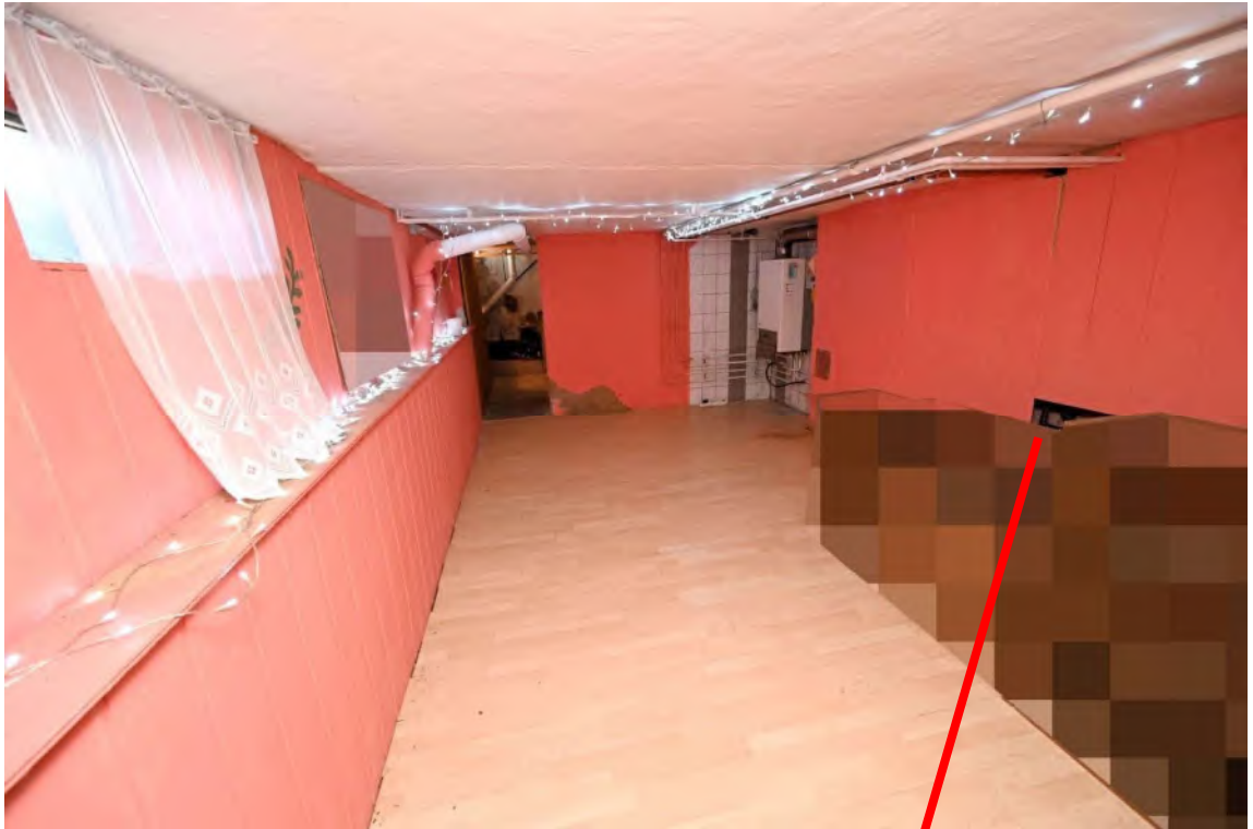
Abb. 9: Gebäude A, Teilkeller, Heizung
