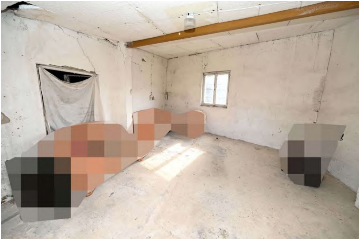
Abb. 33: Nebengebäude D, Erdgeschoss
