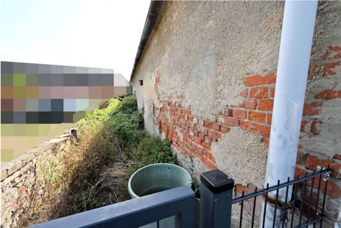
Abb. 35: verwilderter Grundstücksbereich nördlich Gebäude B
