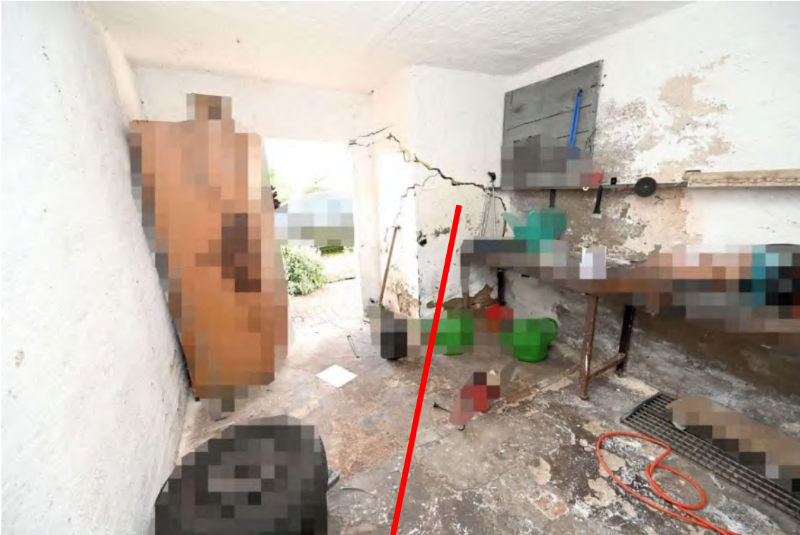
Abb. 27: Nebengebäude B, Erdgeschoss, Werkstatt
