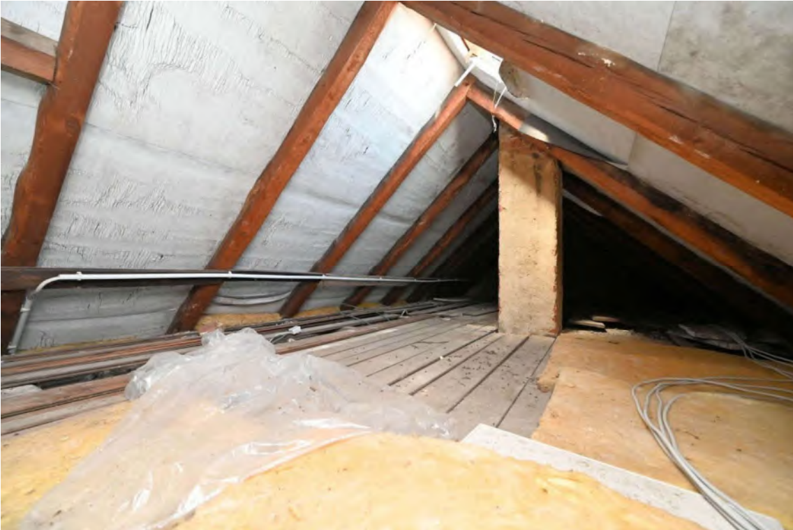
Abb. 23: Gebäude A, Dachspitz
