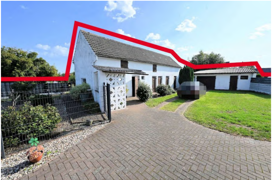
Abb. 25: Nebengebäude B, C und D, Blickrichtung Nordosten
