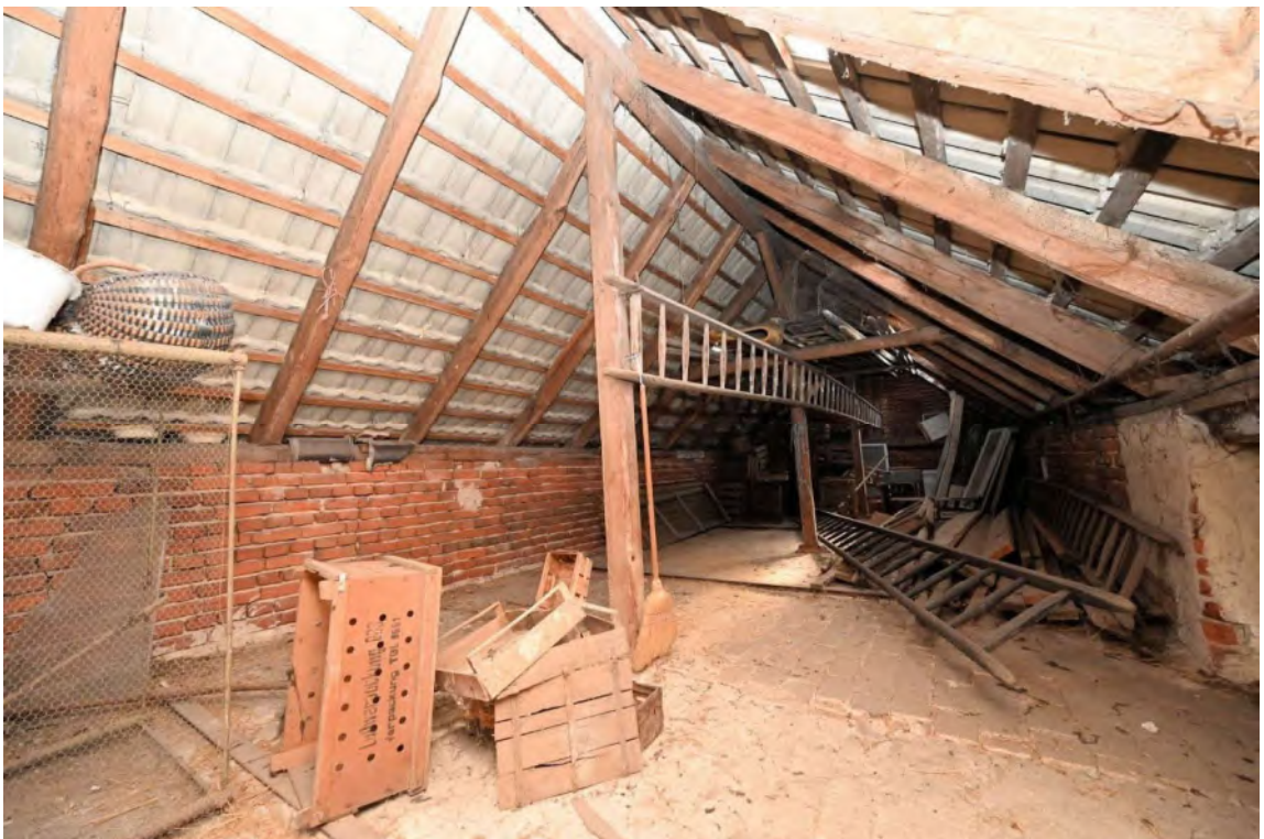
Abb. 30: Nebengebäude B, Dachgeschoss, ehem. Heuboden
