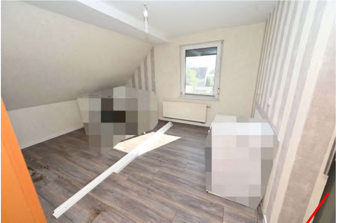
Abb. 21: Gebäude A, Dachgeschoss, Küche mit Übergang Wohnzimmer
