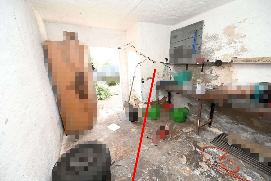
Abb. 27: Nebengebäude B, Erdgeschoss, Werkstatt
