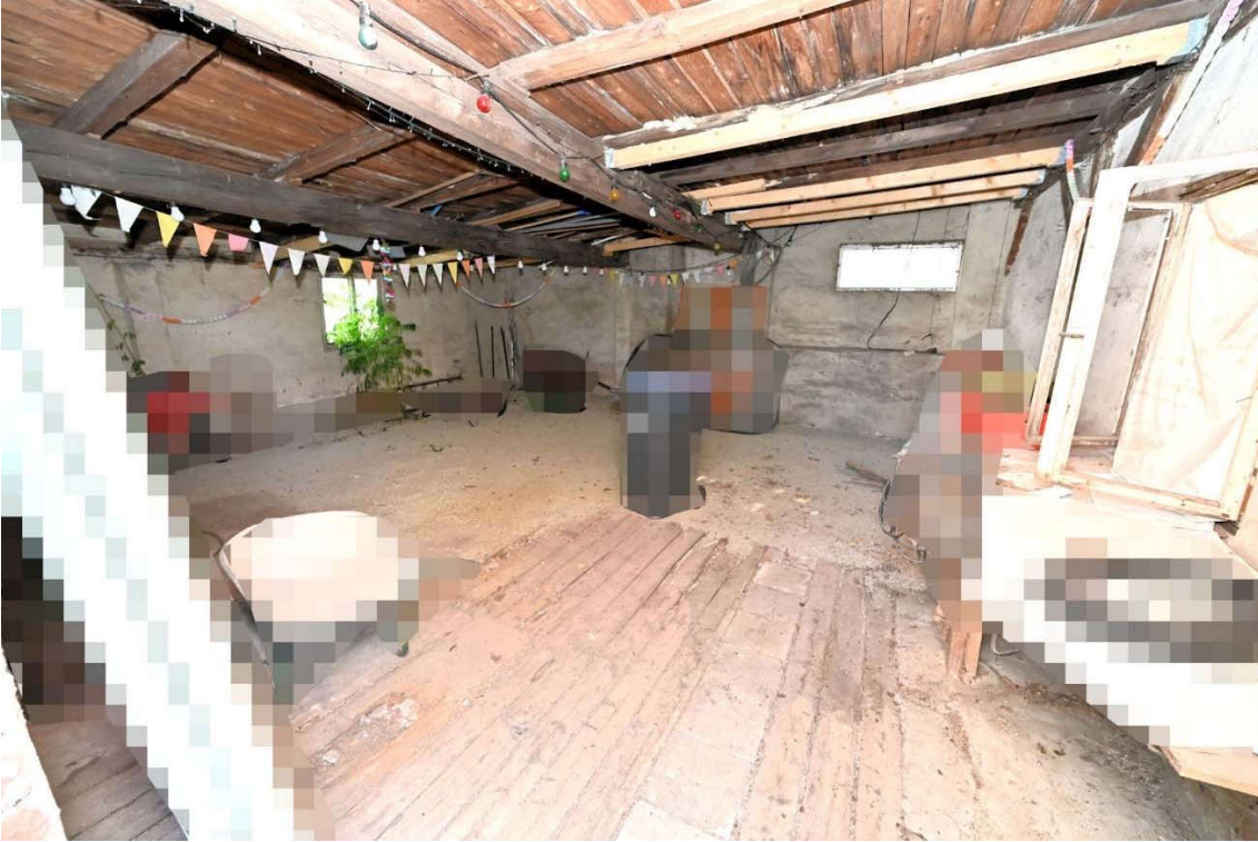
Abb. 31: Nebengebäude C, Erdgeschoss, rechts Fenster zu Gebäude D
