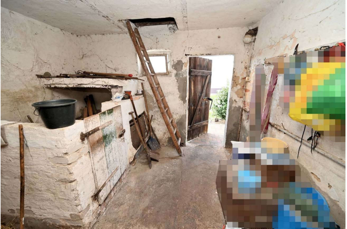
Abb. 29: Nebengebäude B, Erdgeschoss, ehem. Stall
