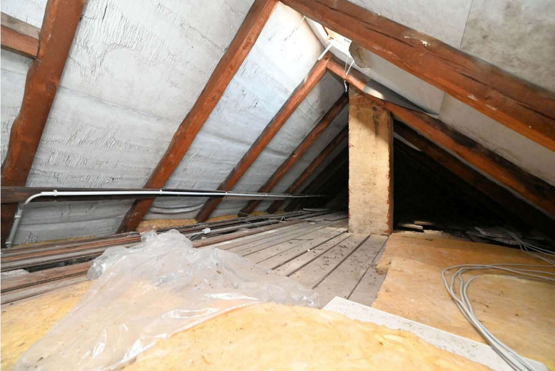
Abb. 23: Gebäude A, Dachspitz
