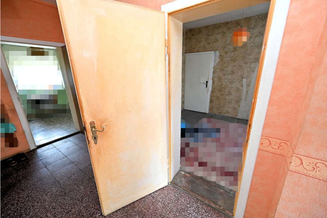
Abb. 11: Gebäude A, Erdgeschoss, Flur mit Zugang Zimmer 1
