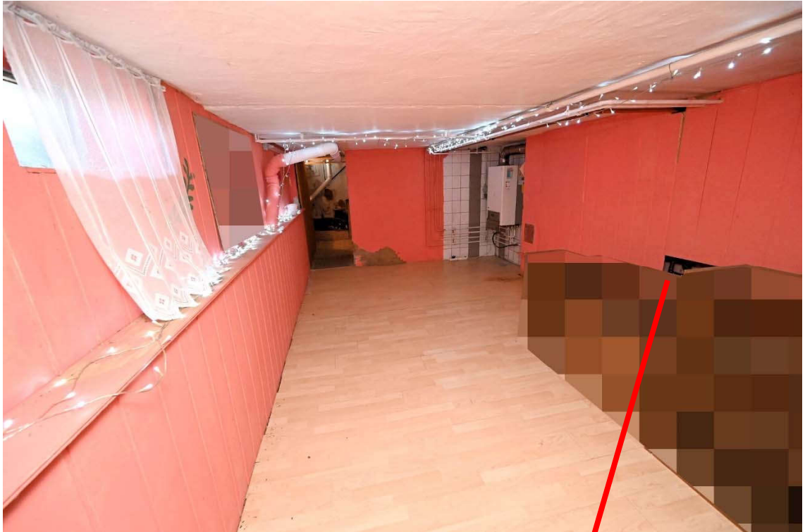
Abb. 9: Gebäude A, Teilkeller, Heizung
