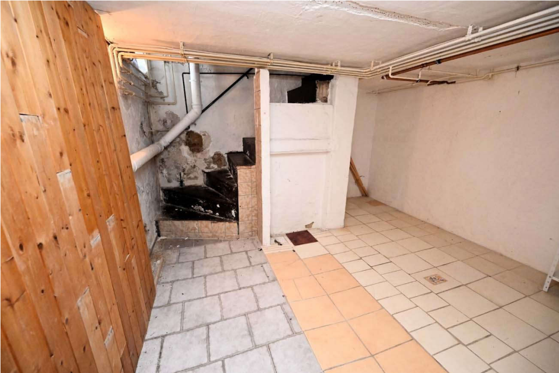
Abb. 7: Gebäude A, Teilkeller
