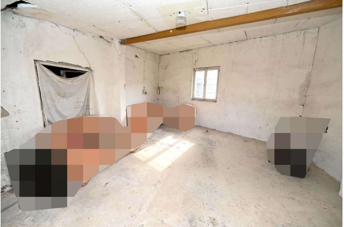
Abb. 33: Nebengebäude D, Erdgeschoss
