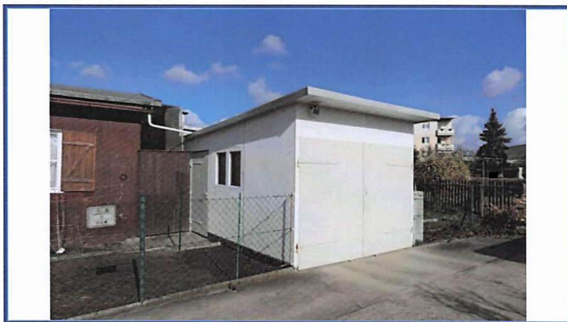
Abbildung 16: Einfaches Garagen-/Lagergebäude; Außenanlagen; umliegende Bebauung
