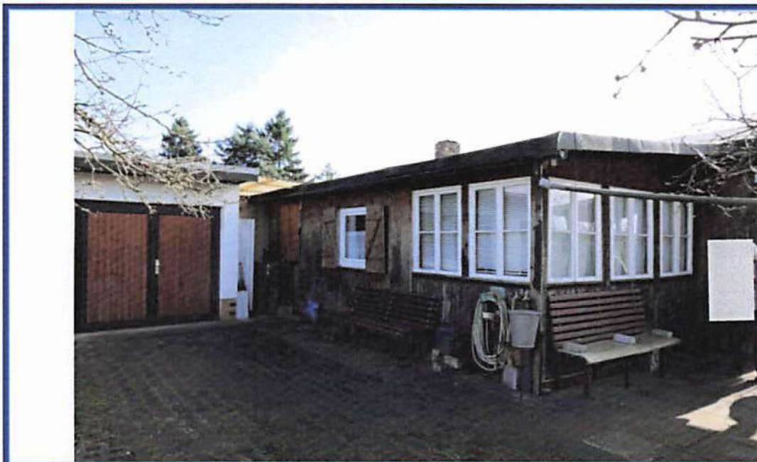
Abbildung 3: West-Ansicht des Bungalows; links das Garagen-/Lagergebäude; Außenanlagen
