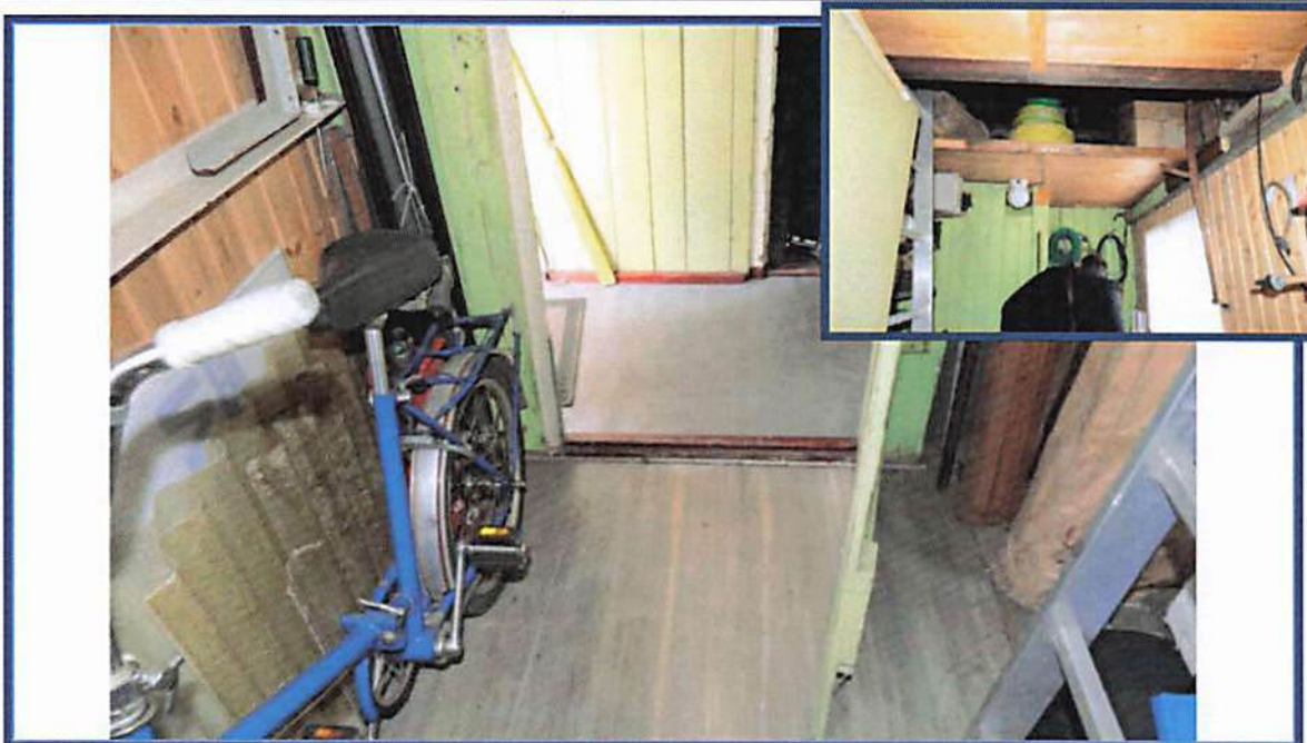
Abbildung 11: Abstellraum im Eingangsbereich; einfache und überalterte Ausstattung
