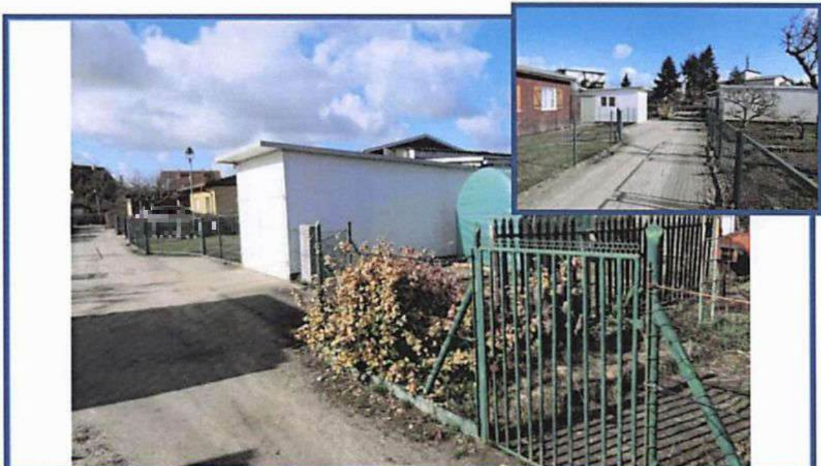
Abbildung 22: Blick in westliche Richtung vom Weg „Fichteplatz“; rechts das einfache Garagengebäude; umliegende Bebauung und Nutzung
