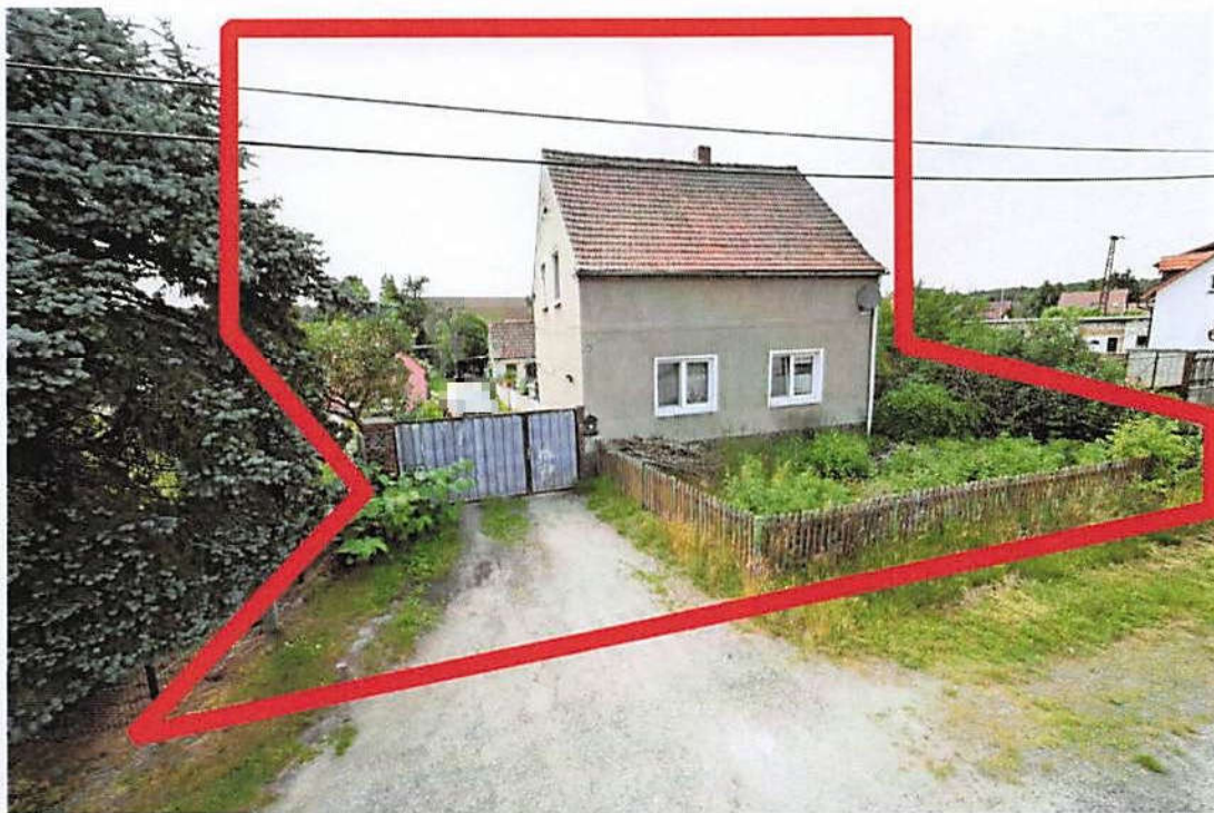
Abb. 4: Grundstücks- und Gebäudeansicht von der Straße
