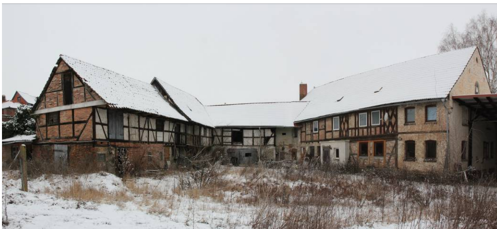
Wohnhaus mit südwestseitigem Nebengelassanbau
